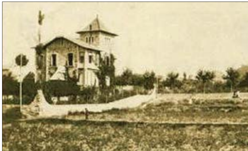
Foto històrica de la torre modernista, a l'indret de la Coma. // F: DIBA
