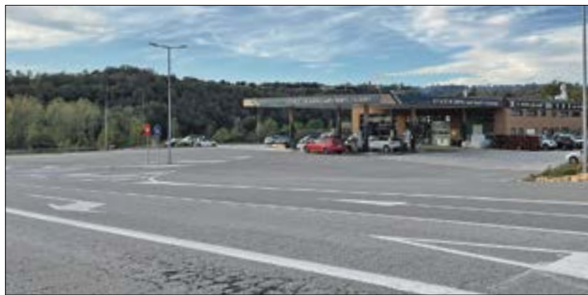
Els accessos de la gasolinera són més curts del que marca la normativa actual.// F: ARXIU
