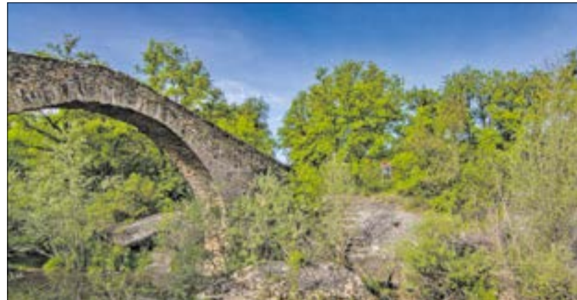
Pont de Sant Martí, a Merlès // F: CONSORCI
