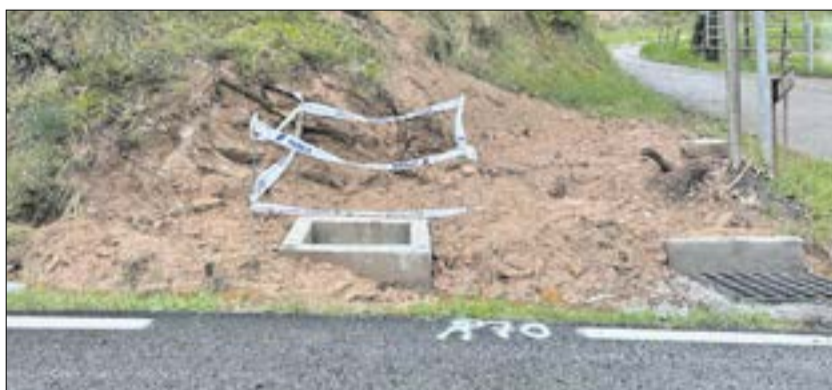
Les obres a la carretera del Collet. // F: AJ SBLL
